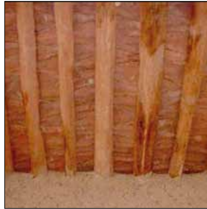
Type A floor (beams & karnef)
